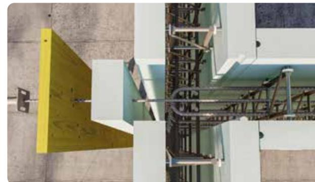
5 Inserir armadura de paredes em T antes da betonagem.
